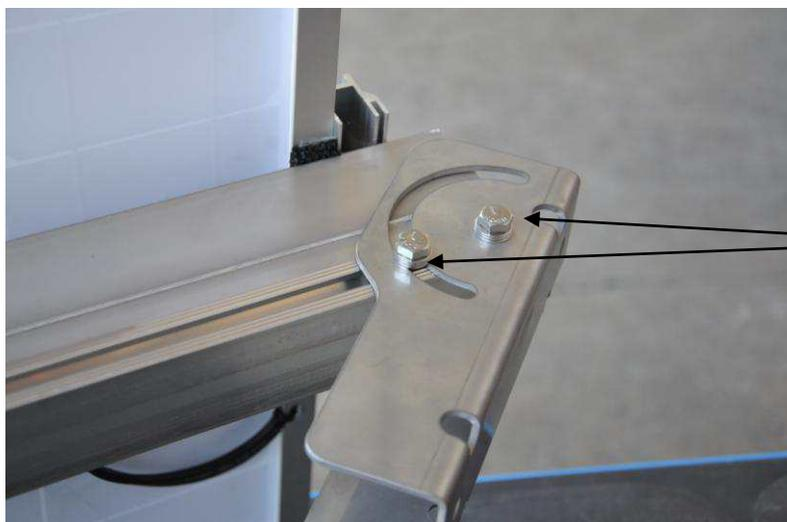
Vis de réglage de l'angle (2 par côté)
